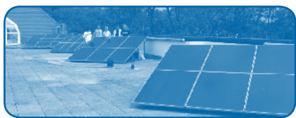
Abbildung 31: Die Anlagen des Energie Teams von Kyocera, Siemens, Mitsubishi II und I (von links nach rechts) und das Energie-Team.
