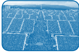
Abbildung 43: 50-kWp Anlage mit monokristallinen Zellen auf dem Dach der Turnhalle Quelle: Gymnasium Eckental
