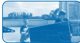
Abbildungen 32 und 33: Modulwechsel und Aufbau einer Solaranlage durch das Energieteam Quelle: Energie-Team o.J.
