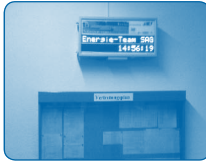
Abbildung 34 und 35: Installation der Anzeigetafel und fertig installiert über dem Vertretungsplan
