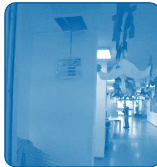
Abbildung 25 und 26: Installierte Anzeigetafel Quelle: DGS
